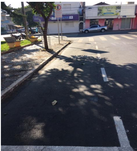
Foto 09 – Sinalização horizontal e vertical
