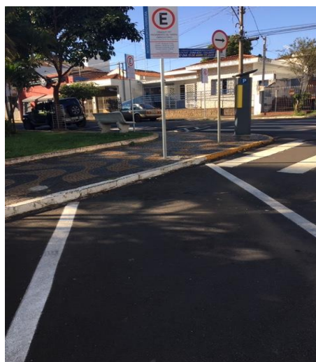
Foto 02 – Sinalização horizontal e vertical
