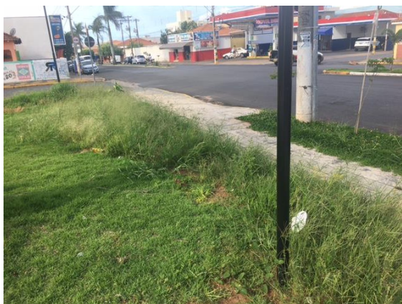
Foto 3 – Não conformidade constatada
