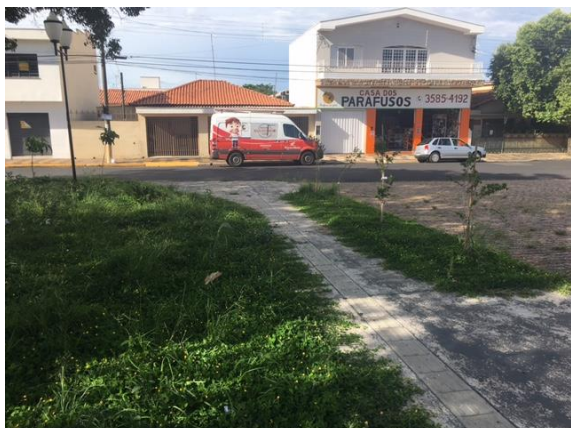
Foto 7 – Não conformidade constatada
