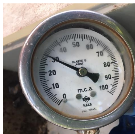
Rua Alfredo Antonini, nº 130
